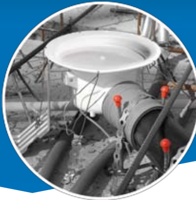
Eksempel på montering av sluk UTEN JAFØ Innstøpningsstativ
